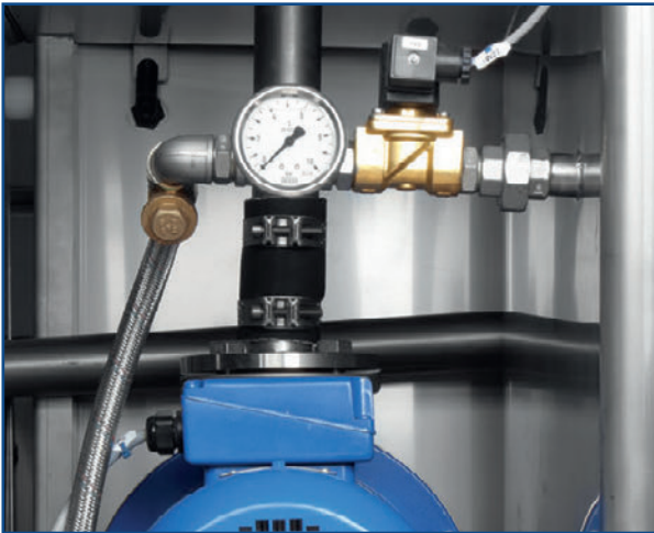
Manometer zur Druckprüfung – einfache Funktionskontrolle
