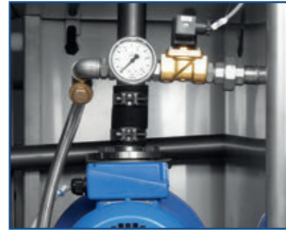
Bild.18 Manometer zur Druckprüfung – einfache Funktionskontrolle
