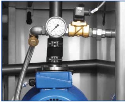
Bild.08 Manometer zur Druckprüfung – einfache Funktionskontrolle
